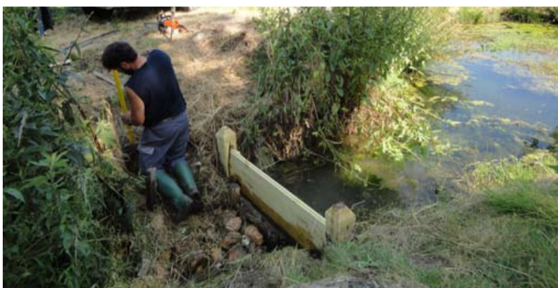
Mise en place de l'écluse
